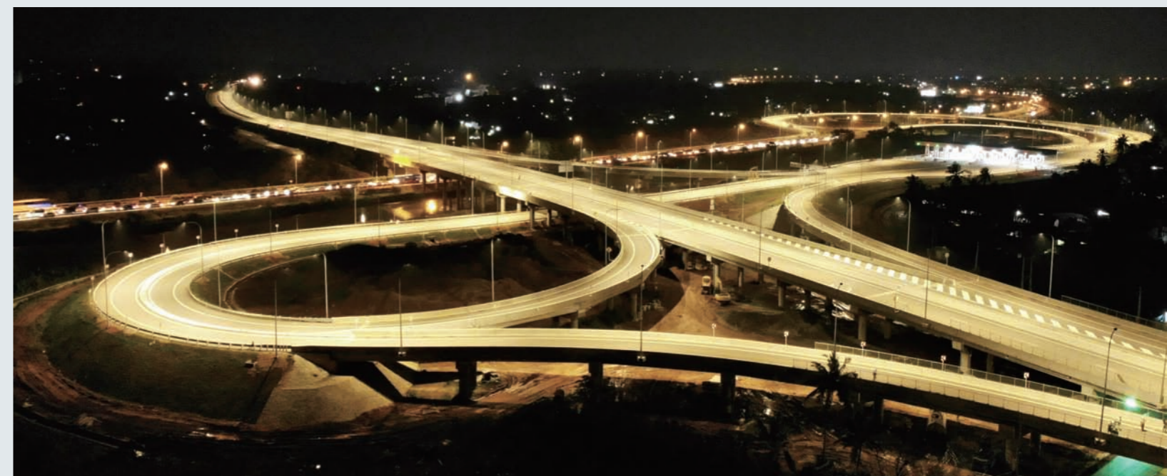
集团斯里兰卡科伦坡外环高速公路北二段(OCH)项目建成通车
