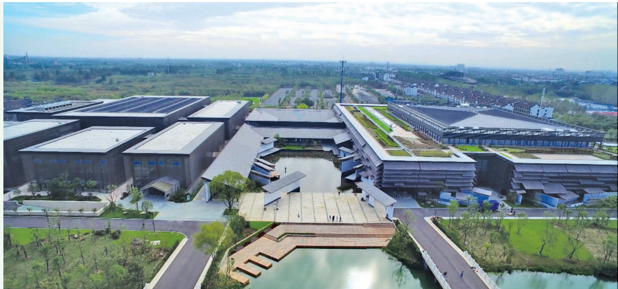
乌镇互联网国际会展中心项目（住建部绿色施工科技示范工程）
