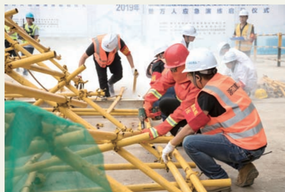
集团建筑施工超高支模架坍塌应急救援演练现场
