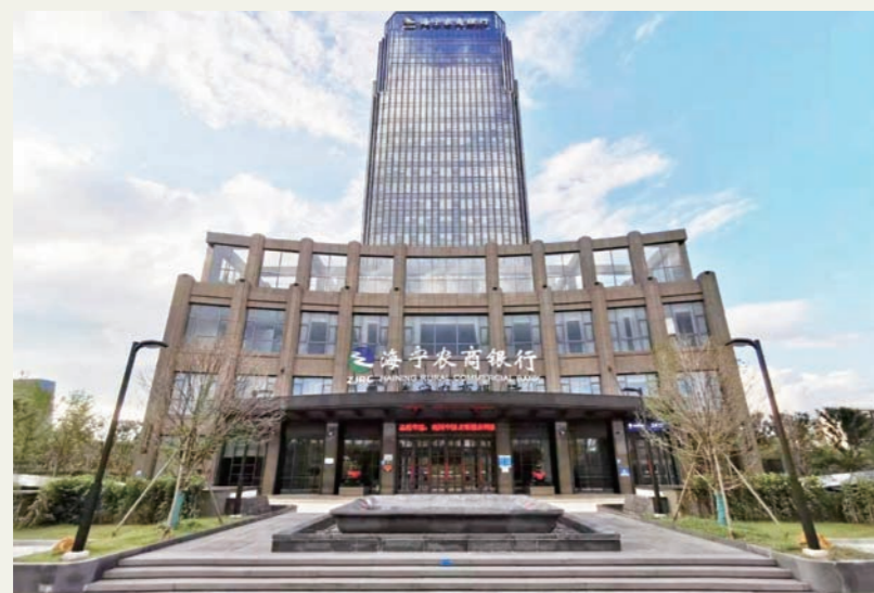
海宁农金大厦项目
