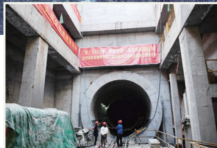
集团1482米超远距离混凝土无接力水平泵送技术创全国纪录
