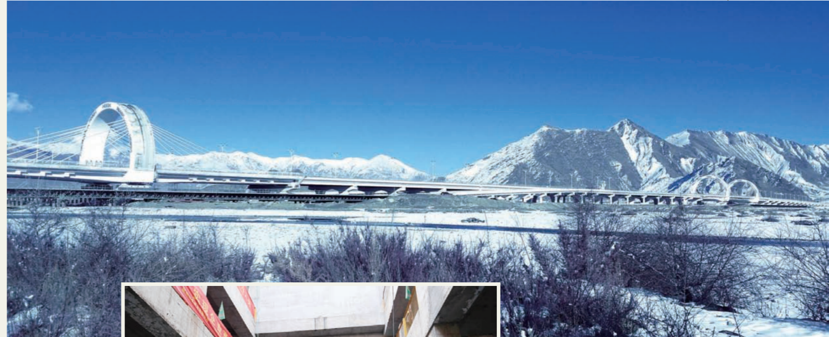
拉萨市柳东大桥工程PPP项目
