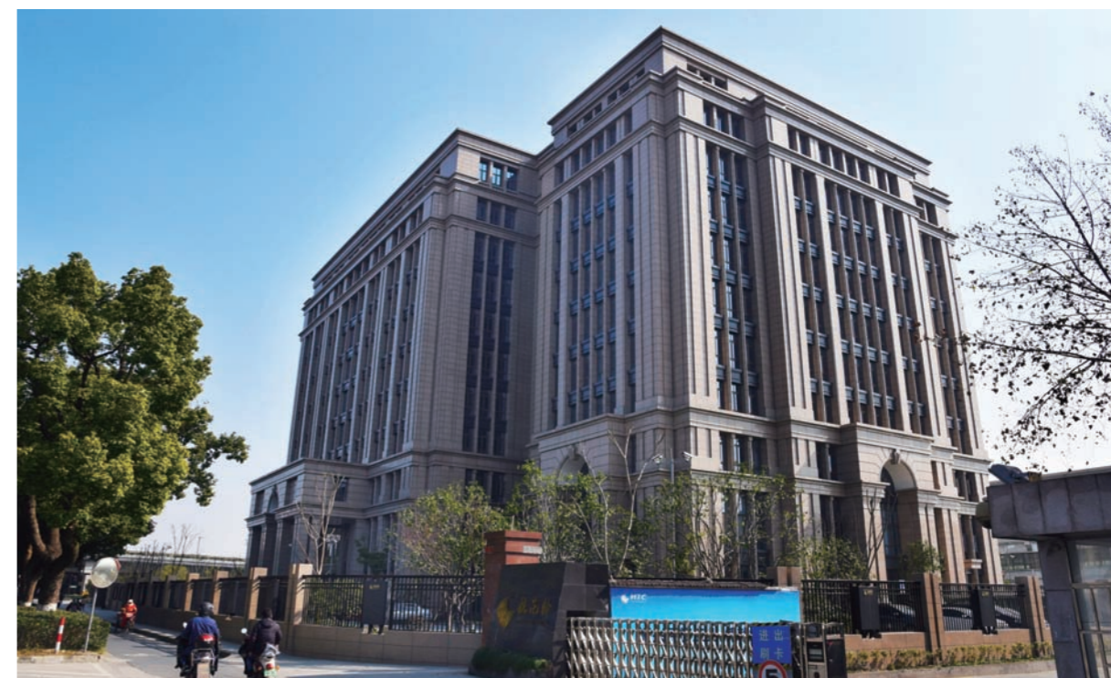
杭汽轮科研大楼（国优奖）
