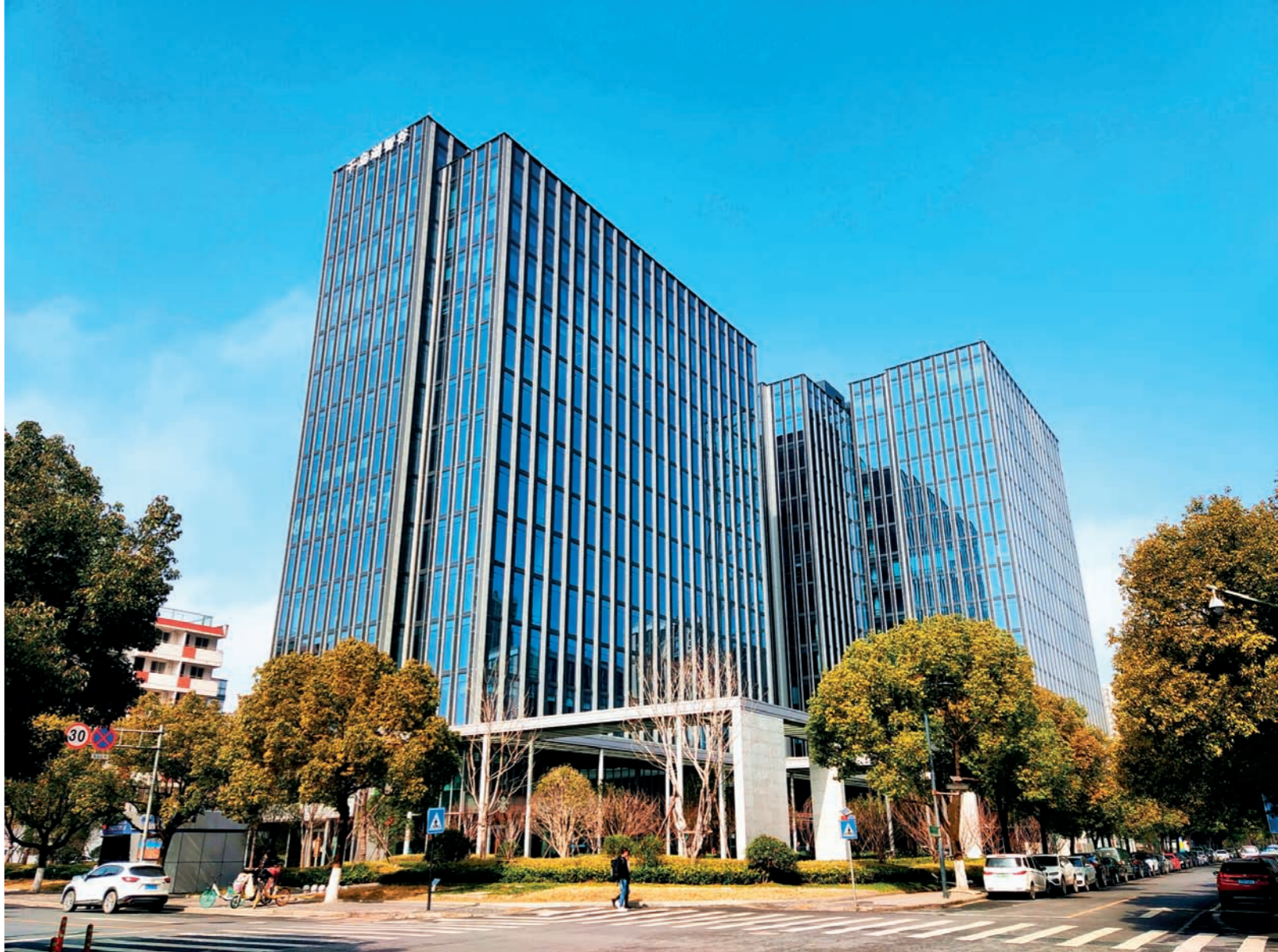
千岛湖智谷大厦（国优奖·浙江建工承建）
