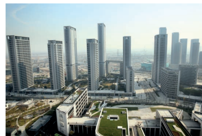
亚运媒体村项目
