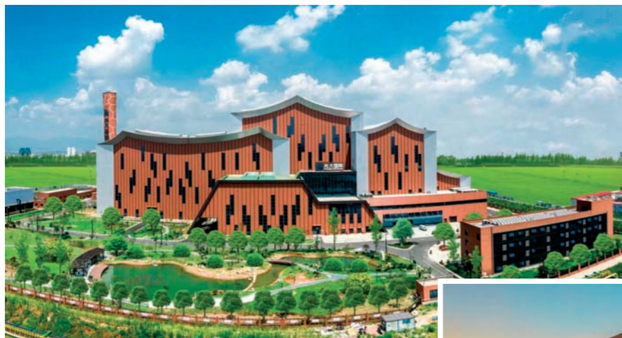
衢州市区生活垃圾焚烧发电项目（鲁班奖·浙江二建承建）
