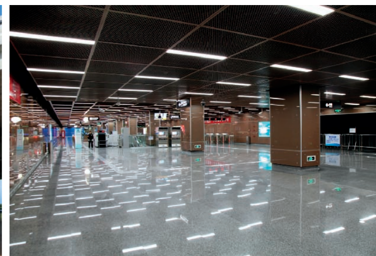
宁波市轨道交通3号线一期工程（詹天佑奖·浙江二建参建）
