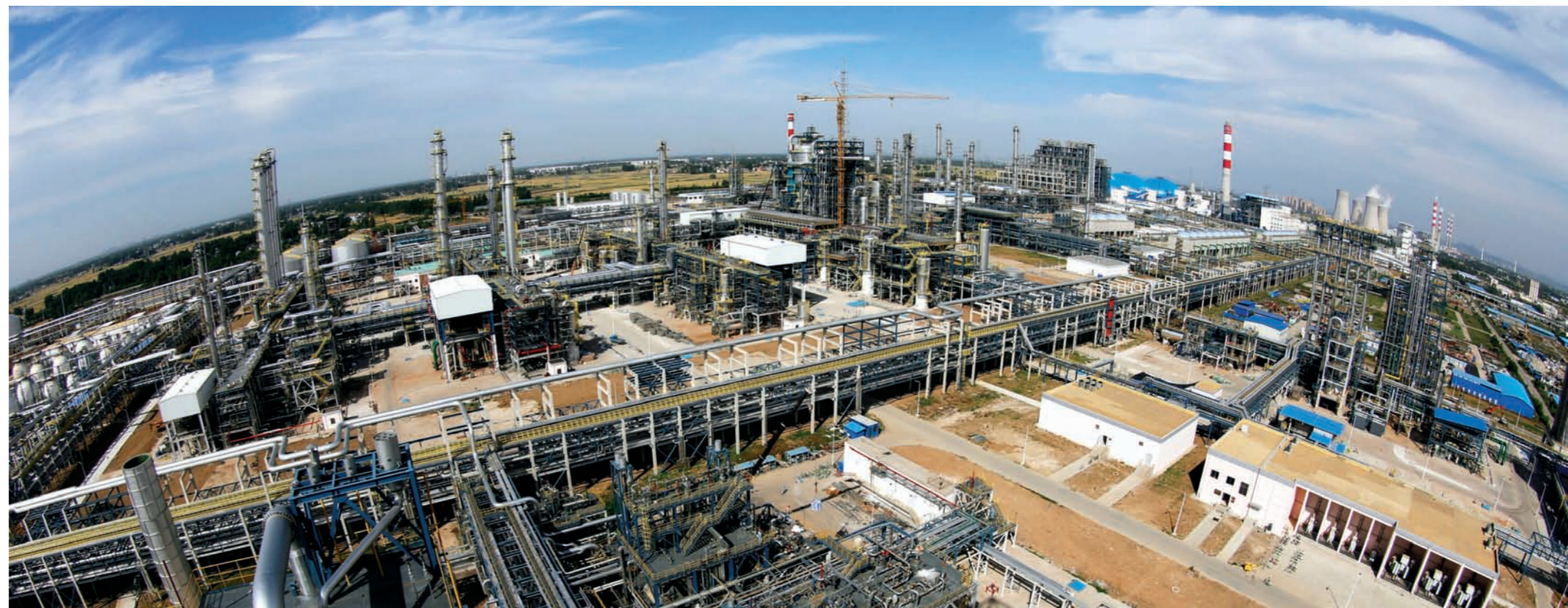
中安联合煤化有限责任公司煤制170万吨年甲醇及转化烯烃项目（国优奖·浙江安装参建）
